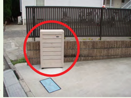
コンクリート工事例
